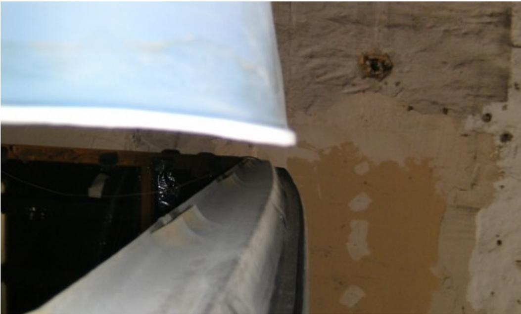
Dachrand mit Multitool und Schleifpapieraufsatz sauber auf ein Maß gebracht.
